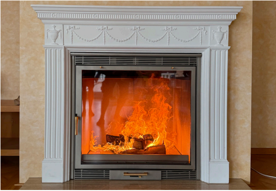
Ein offenes Cheminée hat einen Wirkungsgrad von circa 15 Prozent; mit der leistungsstarken und umweltfreundlichen Hein-Heizkassette erreicht es einen geprüften Wirkungsgrad von 82 Prozent, auch reduziert sich der Feinstaub von 500 mg/m3 auf nur noch 37 mg/m3.
